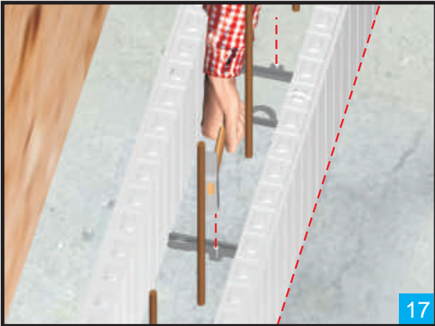
17 Fixez l'ensemble de la structure à l'aide de pointes 3,2x40mm aux emplacements prévus.
