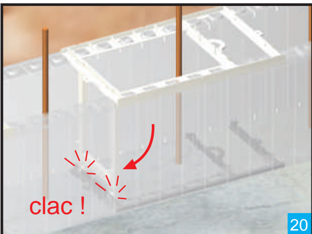
20 Accrochez les écarteur blancs aux écarteurs bas en verrouillant la partie mobile de l'écarteur supérieur sur l'écarteur inférieur.
